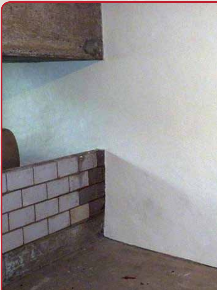
Heizraum in einem Mehrfamilienhaus
