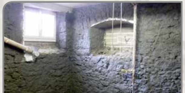
Abspitzen des Putzes bis zur Grundmauer
