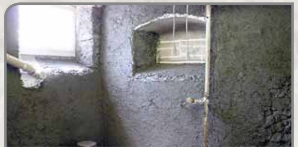
Schichtweises Auftragen der Putzlagen.
