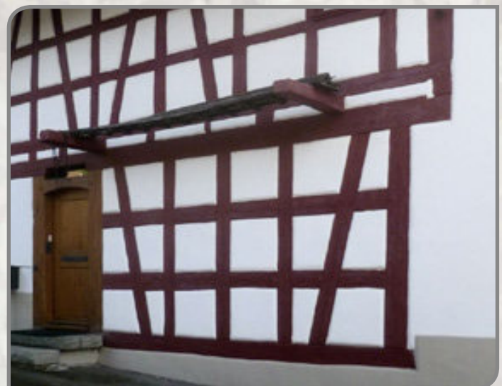
Sockel und Fassade inkl. Riegelfelder wurden saniert mit Hydroment-Transputz LP
