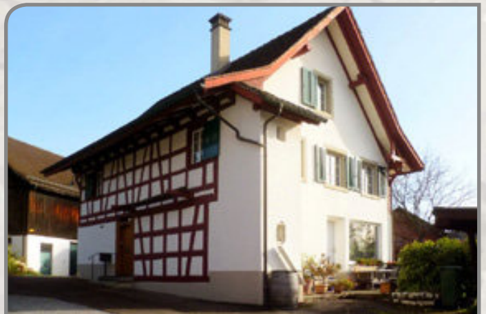
Sockel und Fassade inkl. Riegelfelder wurden saniert mit Hydroment-Transputz LP
